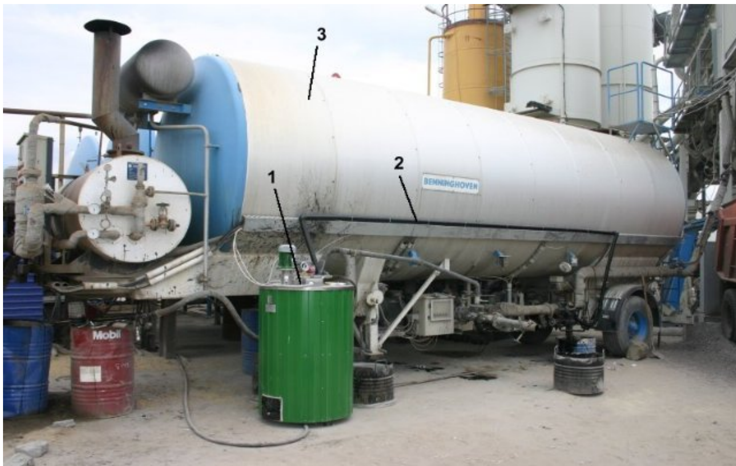
Рис. 3. Линия ввода адгезионной добавки, смонтированная на мобильном АБЗ Benninghoven.
